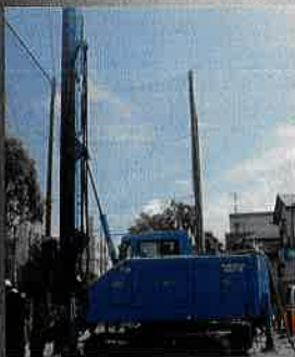
クローラー式杭打ち機
