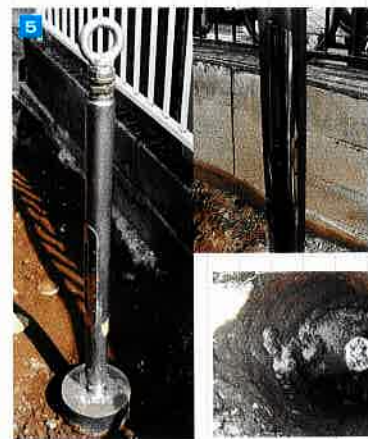
杭頭直接打撃時の全体
